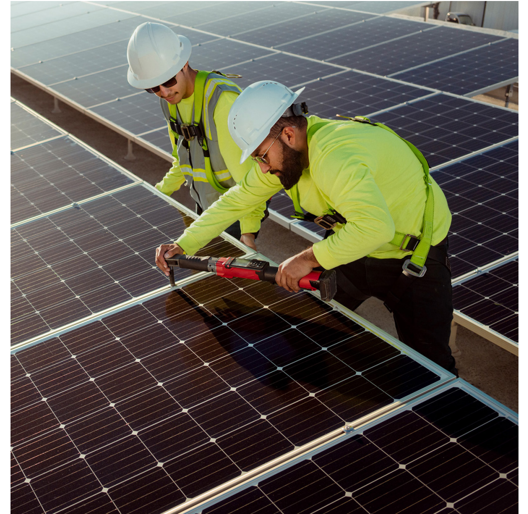
Los técnicos de Simmitri realizan el mantenimiento de los paneles solares instalados en Bench-Tek Solutions en Santa Clara, California. Ambas empresas son exalumnos de Impact Accelerator de Apple.
